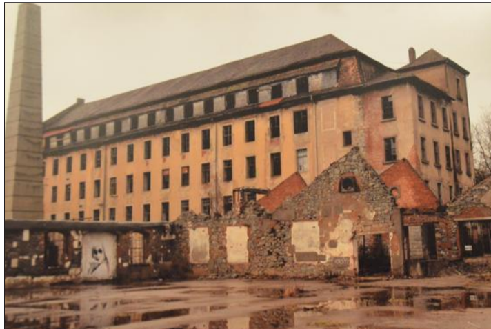
Les bâtiments industriels du Parc de Wesserling à l'abandon.
